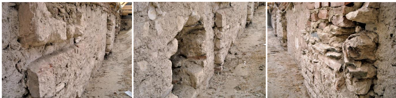
19-21. kép – A tetőtérben a középkori falpillérek az északi falon, jól látható az egykori famennyezet szintje. Még ebben a magasságban is rengeteg római épületkő található a falban
